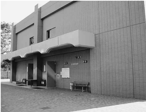
写真7 爆発衝撃実験棟外観
