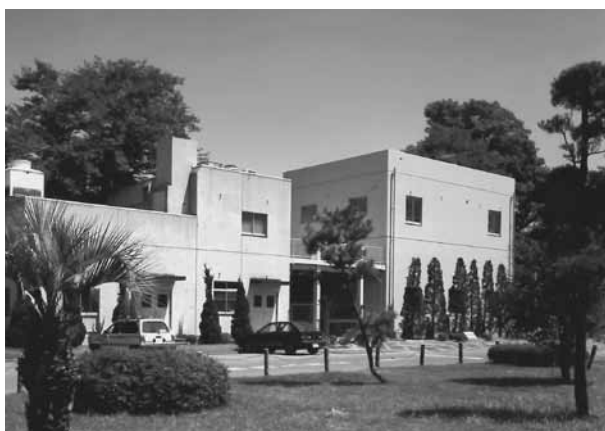
写真2 無機系廃液処理施設更新後の廃液処理施設 首藤征男氏提供
