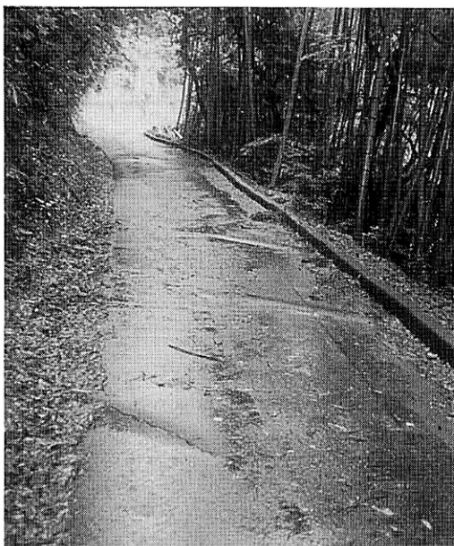
PHO. -6 : 道路の変形（道路舗装がなされた後に土塊が移動したため、路面が波うつように変形した。）
