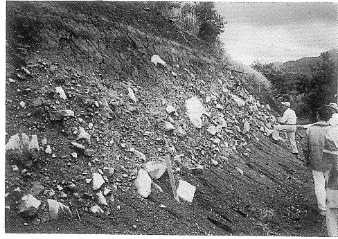
写真1 松の台岩屑なだれの露頭写真
