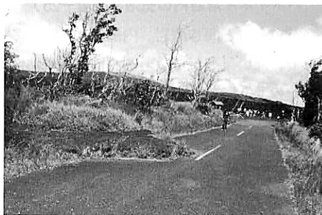
写真一19 溶岩流による道路の破壊
