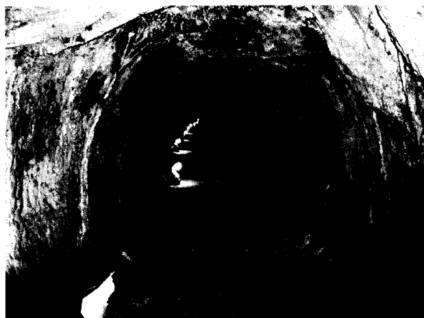
図2 トンネル内観 (南口から約200m 付近)
