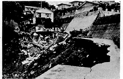
写真-1 熊本市池田町3丁目の崩壊
