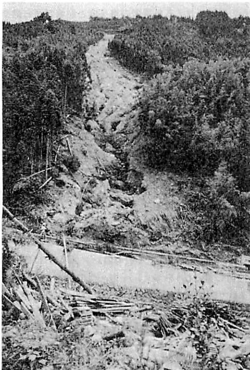
写真-2 八代郡坂本村岳部落の崩壊
