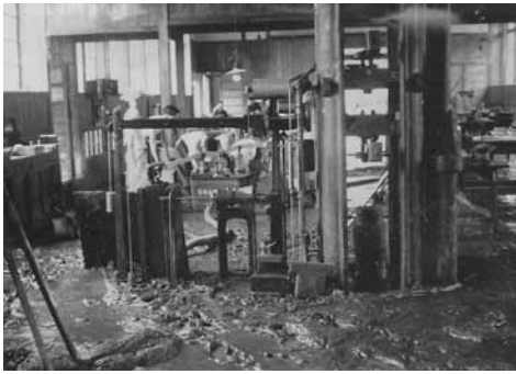
写真1 黒髪キャンパス(工学部)の被害の様子
