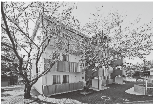
写真5 国際交流会館新棟（C棟）外観（2009年）
