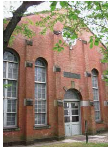
旧熊本工業専門学校機械実験工場 (工学部研究資料館)
