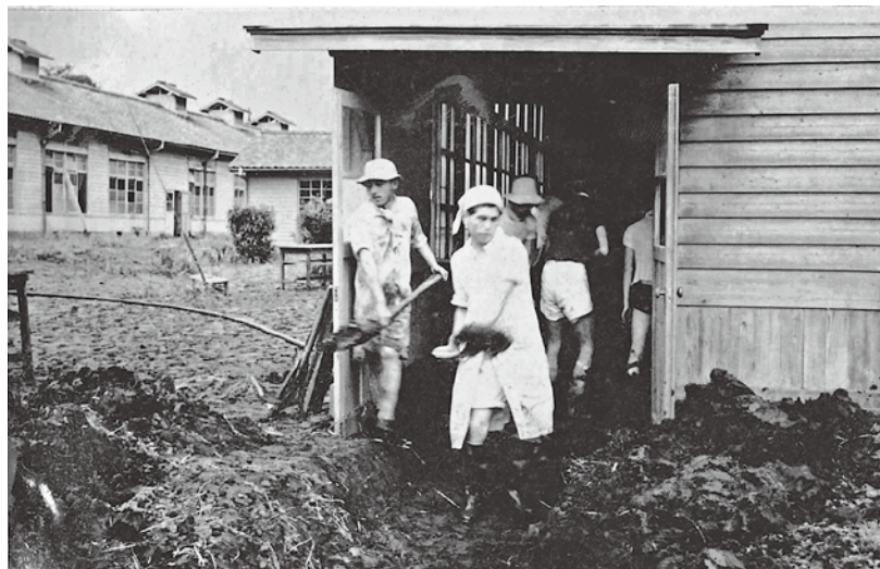
熊本大水害後 研究室からの泥土排出◇1953年
