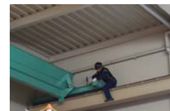
写真 2 走行レールの点検
