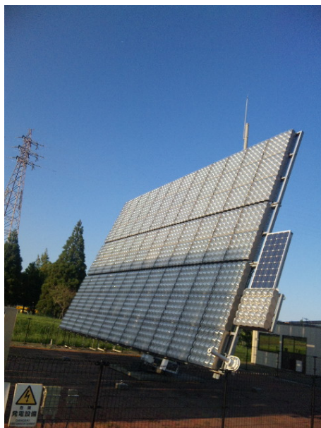
写真.1 レンズ集光型太陽光発電システム(太陽追尾型)
