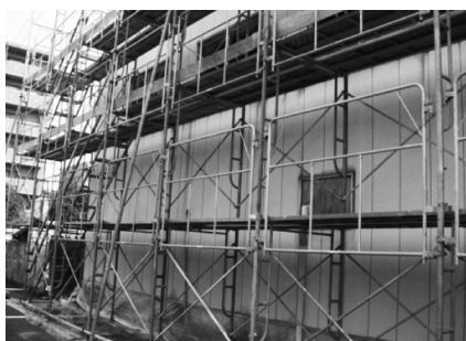
(図 18) ②4段の足場設置
