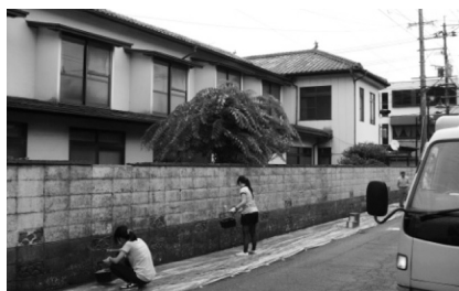
(図3) ③下地材(シーラー)塗り
