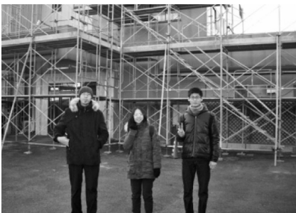
(図34) ②4段の足場設置
