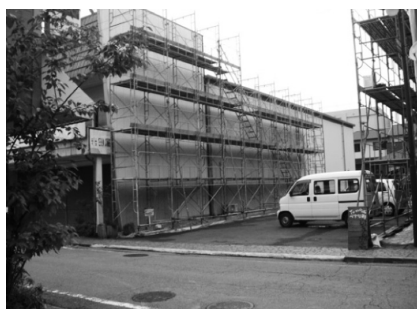
(図 22) ②4段の足場設置
