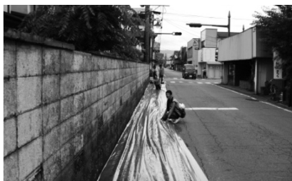
(図2) ②養生シートを張る
