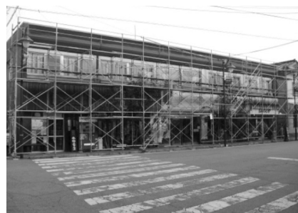
(図 30) ②3段の足場設置
