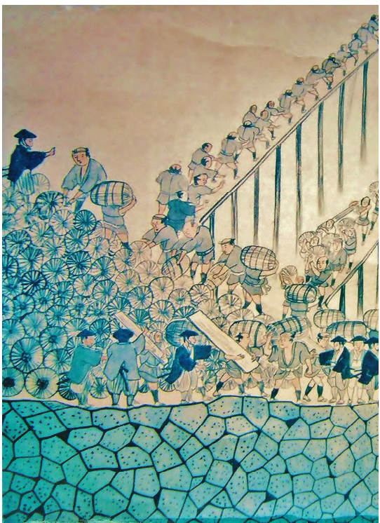
【⑰道橋は安全のため一方通行に規制】
