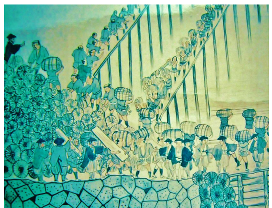
【⑯錯綜する馬踏（堤防上部）】
