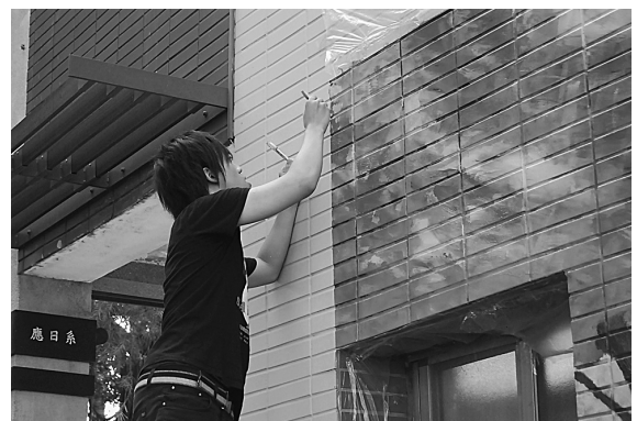
図21 シート剥がしと縁部分の仕上げ
