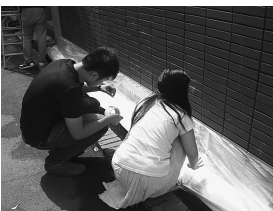
図3 養生シート張り
