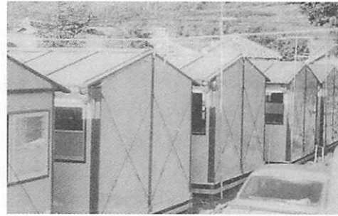
写真一 6 密集した仮設住宅 (写真所蔵：天草市倉岳支所)
