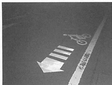
写真-1 北区清水新地の路面舗装（東区下南部3丁目13番13号交差点、北区清水新地5丁目1番1号付近）
