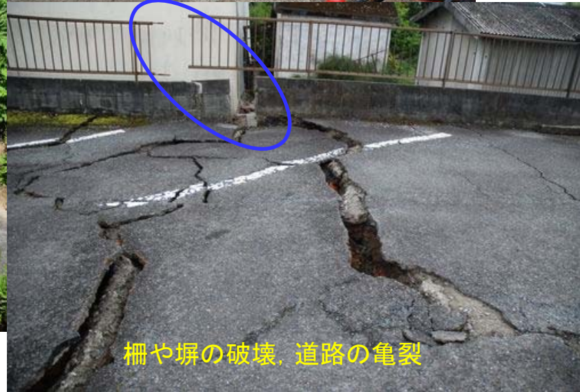
液状化による土台の沈下(段差20cm)
