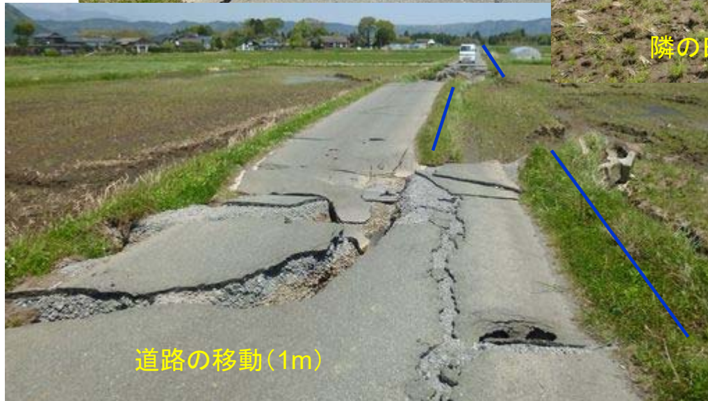
役犬原農道の陥没
