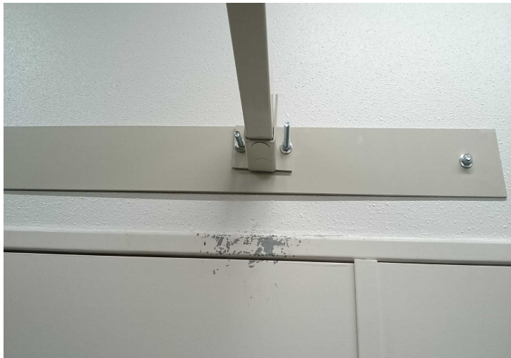
2016. 10. 6撮影 中央館2F 書架上部つなぎ (壁固定部)
