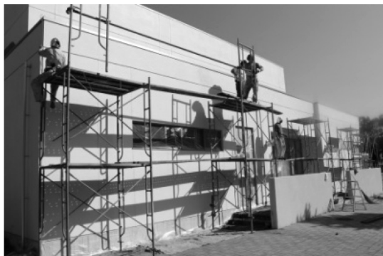
(図 15) 足場設置・養生
