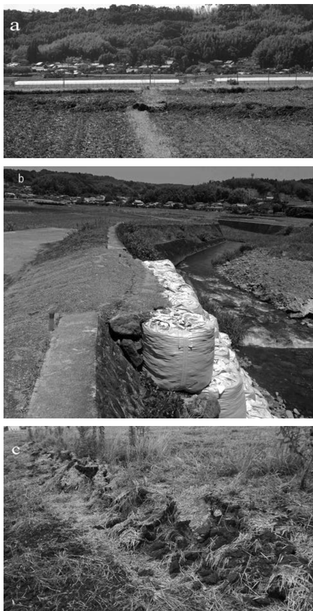
図4 N65° E系列地表地震断層に見られる変位 a: 水平変位約 50cm, 垂直変位約 40cm の右横ずれ断層 (北側が隆起) b: 金山川の護岸の右横ずれ変位 c: 左雁行配列の開いた割れ目
