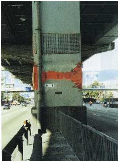
鋼製箱形断面橋脚の 局部座屈
