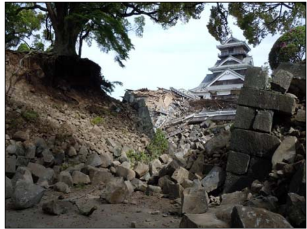
熊本城石垣崩壊(熊本市)
