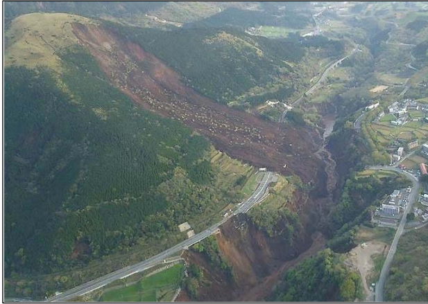
国道57号斜面崩壊(南阿蘇村)
