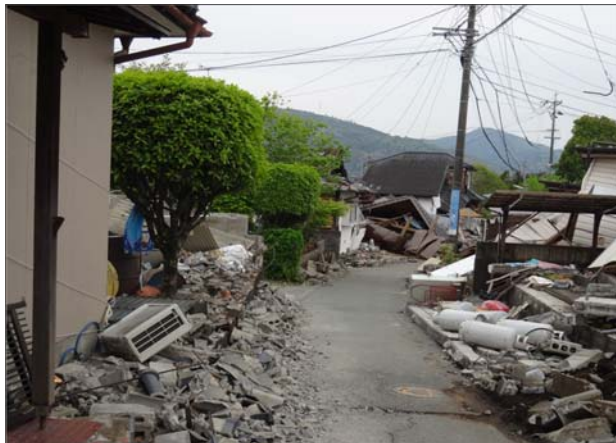
住宅倒壊(益城町)
