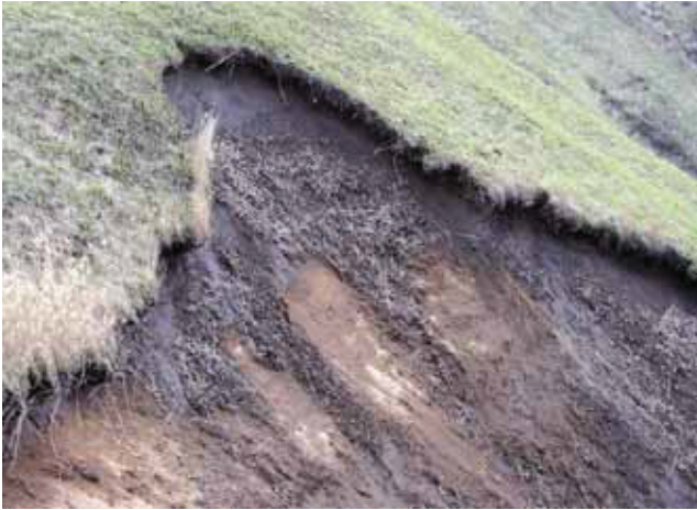
写真-3 阿蘇火山における2001年6月29日崩壊の滑落崖とすべり面
