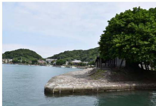
写真-1 三角西港石積護岸（2016.6.7）
