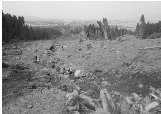
写真-13 崩壊地全景(浄土寺跡付近から下流側)
