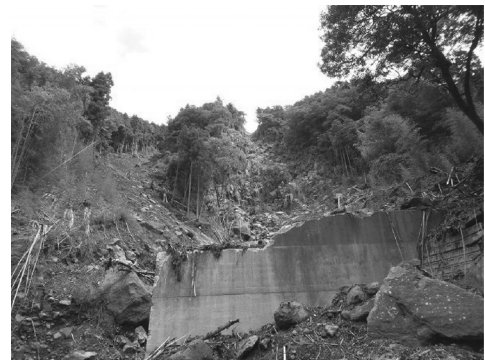
写真-6 崩壊型土石流の例（塩井川 1）
