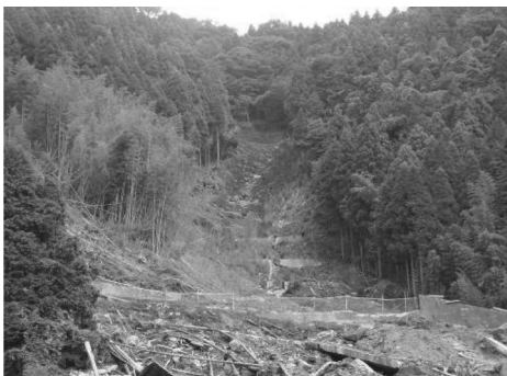
写真-10 急斜面の表層崩壊の例（古閑地区 1）
