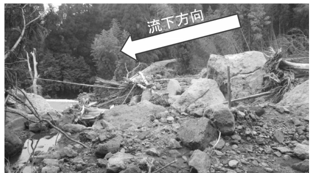
写真-18 塩井川砂防堰堤上流に堆積した土砂
