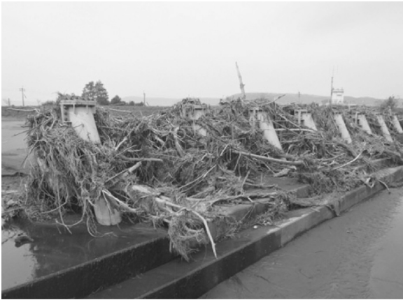
写真-21 一の宮多目的貯水池 (熊本県管理)
