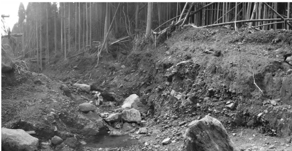
写真-3 土石流流下区間の浸食状況（下流から撮影）
