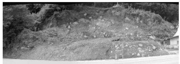
写真-12 斜面崩壊の例（古閑地区 2）
