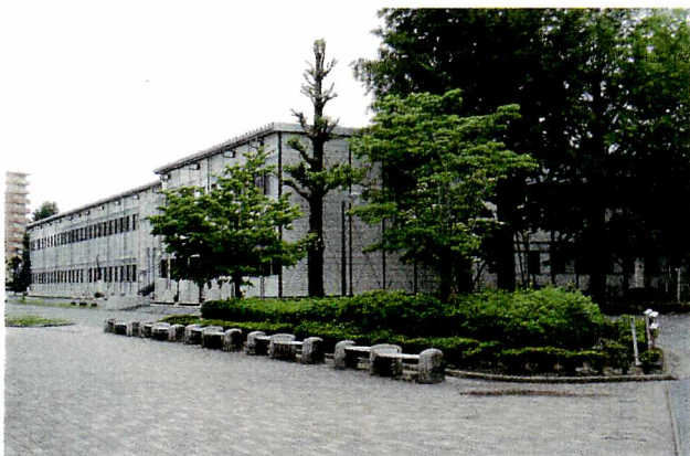
図1 熊本大学工学部の仮設プレハブ校舎
