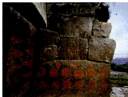
第 4 図 前室部東側壁（整備前）
