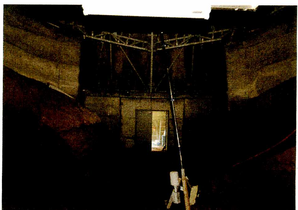
第 15 図 永安寺西古墳被災状況 前室→羨道
