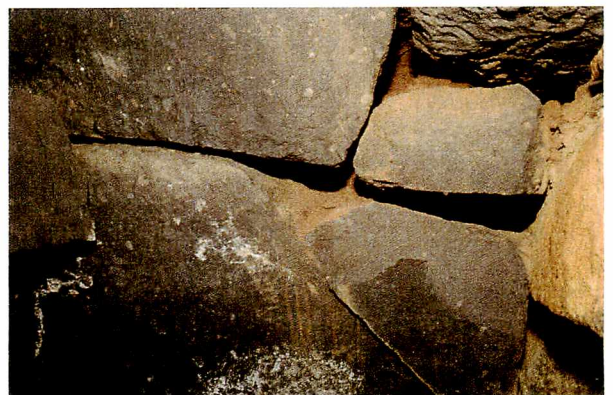
第 10 図 永安寺東古墳玄室東側壁被災状況
