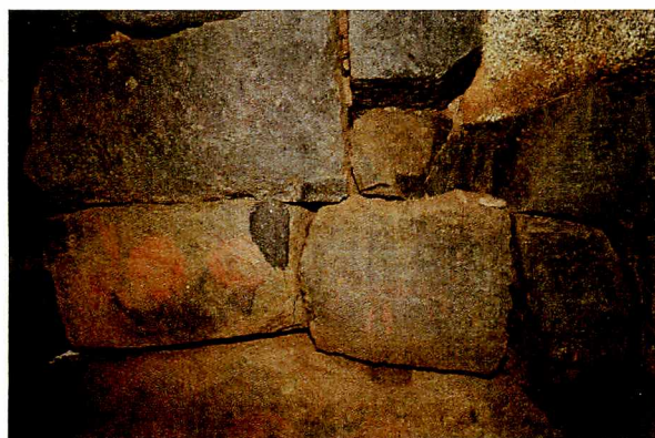
第 9 図 永安寺東古墳前室西側壁被災状況
