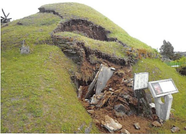
図4 【被災後】釜尾古墳（熊本市）
