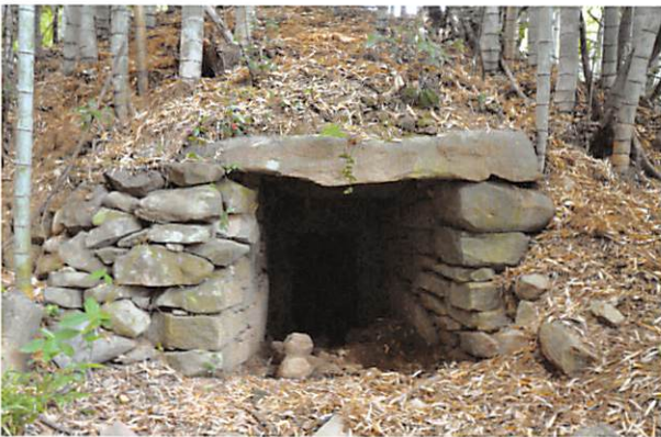
図5 〈被災前〉二軒小屋古墳（熊本市）
