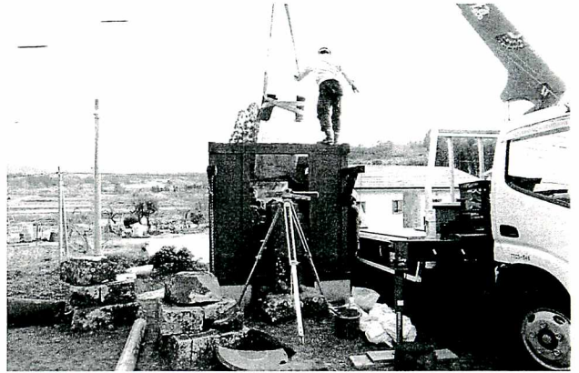
図3 浄水寺碑群南大門碑の再設置作業 (2017/3/28)
