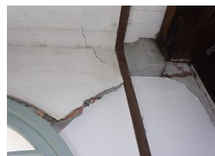
写真3. 亀裂が入った外壁 写真4. 亀裂が入った内壁
