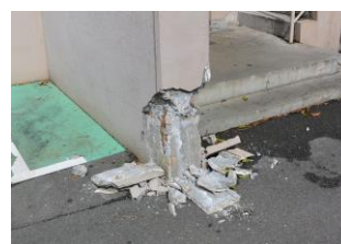
写真1. 亀裂が入った壁 写真2. 剥き出しになった鉄筋
