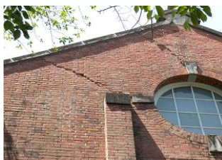
写真3. 亀裂が入った外壁 写真4. 亀裂が入った内壁
