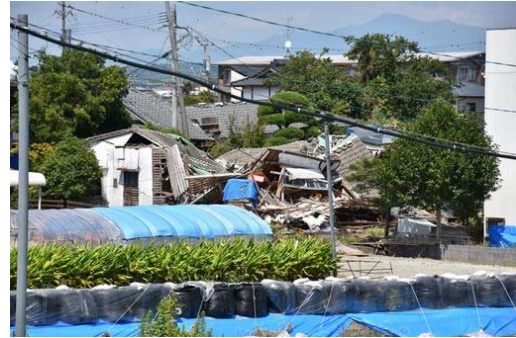
図1 益城町被災状況（益城中技術室から撮影）
