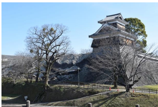
被災し崩壊した熊本城石垣の一部
