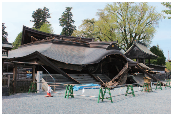
図 21 2016 年 4 月 16 日未明の熊本地震本震で倒壊した阿蘇神社楼門 (国指定重要文化財).
