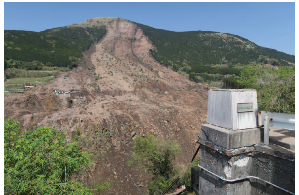
図 9 2016年4月16日未明の本震によって発生した阿蘇カルデラ西壁の大規模崩壊と倒壊した阿蘇大橋 (南阿蘇村).
