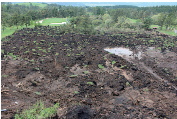
図 15 斜面崩壊 (図 14) に伴う岩屑なだれ堆積物.
