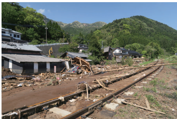
図 18 斜面崩壊に伴う土砂氾濫で被害を受けた住宅と JR 豊肥線 (南阿蘇村立野).
