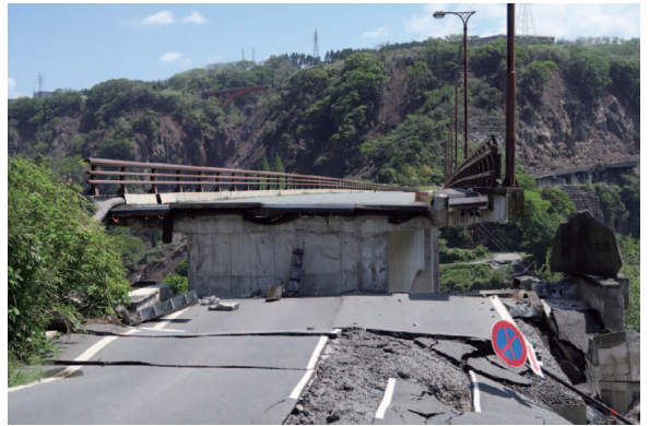
図 7 道路と分離された阿蘇長陽大橋 (南阿蘇村立野).
