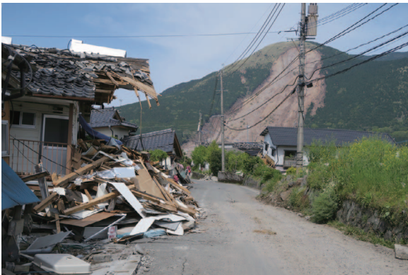
図 8 南阿蘇村黒川における建物被害の状況.
