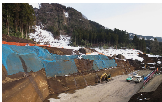
図 3 2012 年 7 月の九州北部豪雨による災害発生地点で砂防堰堤建設のために掘削された断面の全景 (2014 年 2 月 25 日撮影)。写真奥にはおもに Aso-1 火砕流堆積物からなるカルデラ壁が見え、地表付近には 2012 年 7 月ラハールで運搬された巨礫が散在する。
