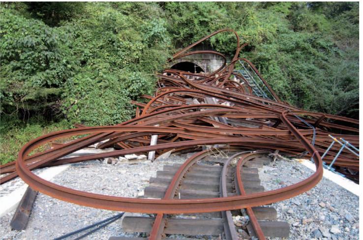
図 9 トンネルから流出し、ねじ曲げられた線路 (JR 豊肥本線坂ノ上トンネル西出口)。
