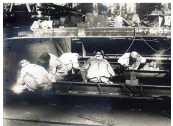
43 三菱重工業長崎造船所での鉸打ち作業
