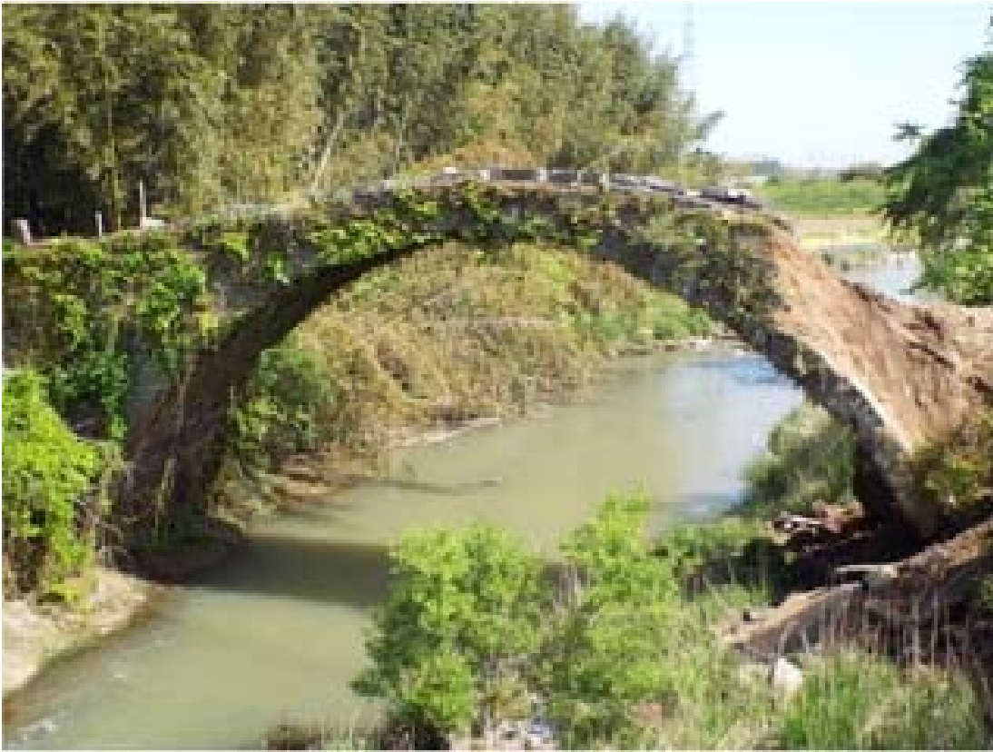
宇城市の下鶴橋の壁石崩壊
