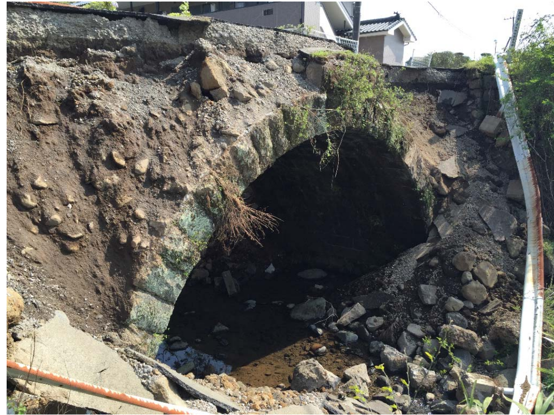
銭瓶橋の壁石崩壊
