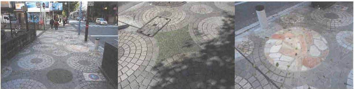
図4 竣工した舗装補修の様子
