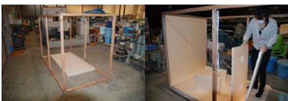
図17 骨組みと壁組立て
