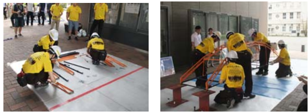
図-4 架設作業写真
