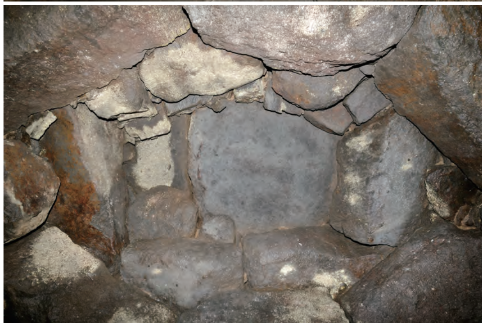
3 上御倉古墳石室の 玄室天井部（右が奥壁側）
