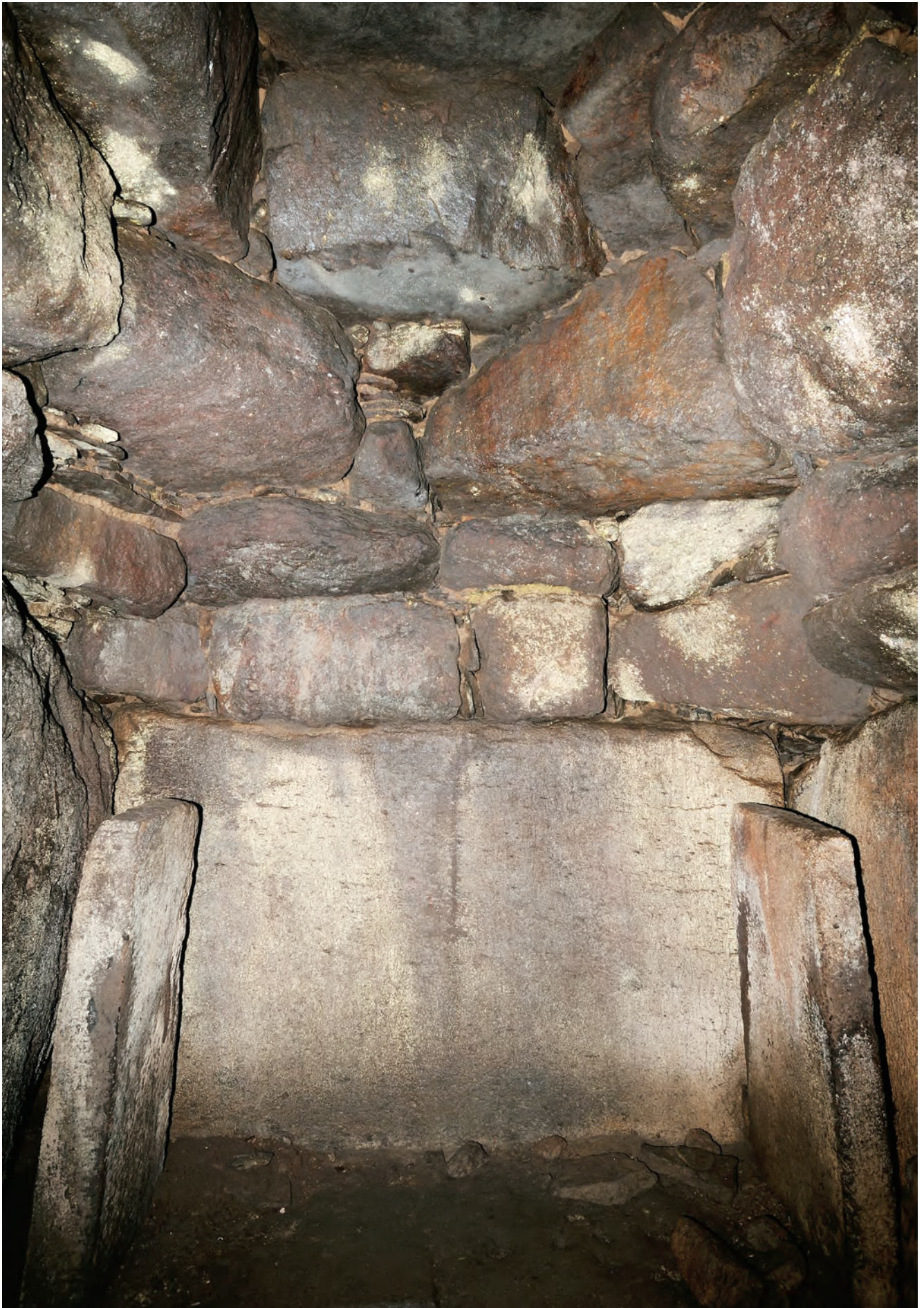
上御倉古墳石室の玄室奥壁
