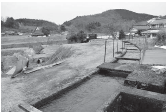
図8. コンクリート製になった水路 (2016年2月19日筆者撮影)
