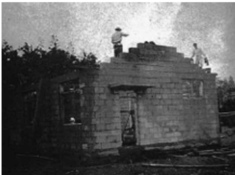
図-2 ブロックによる住宅建設の様子
