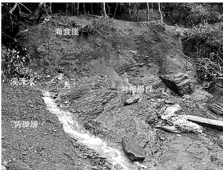
第27図 越高遺跡A地点の背後の溪流からの地表水
