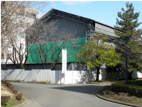
建物外観（西側から撮影）
