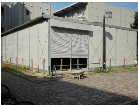
仮設小屋（外観）
