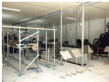
仮設小屋内部（工作機械）
