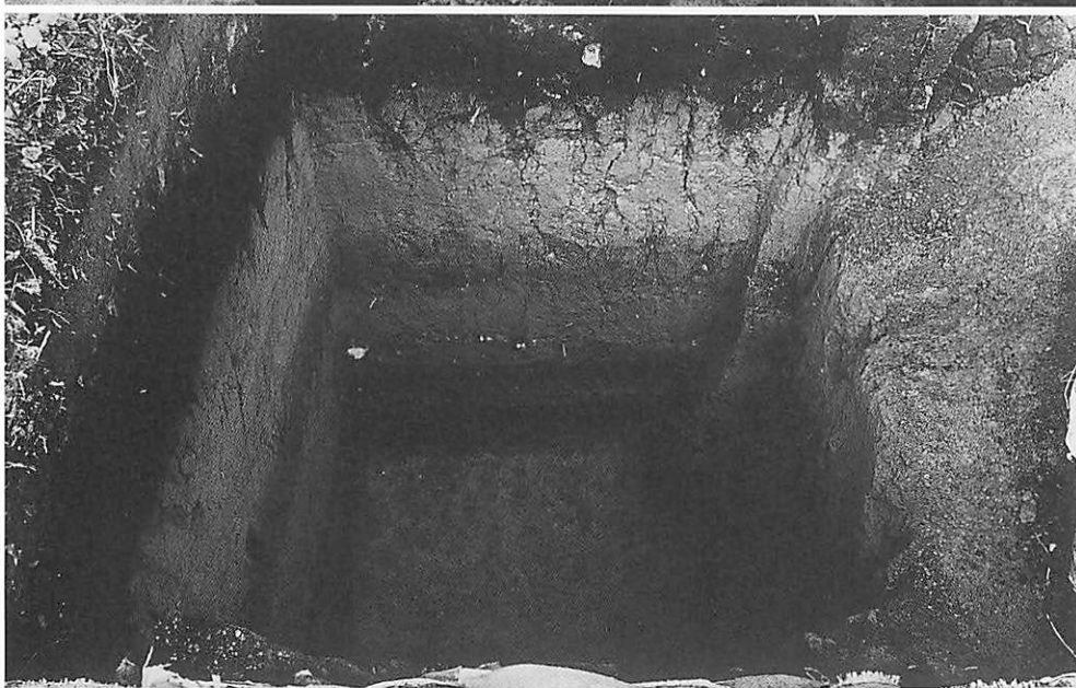
3 トレンチ完掘状況
