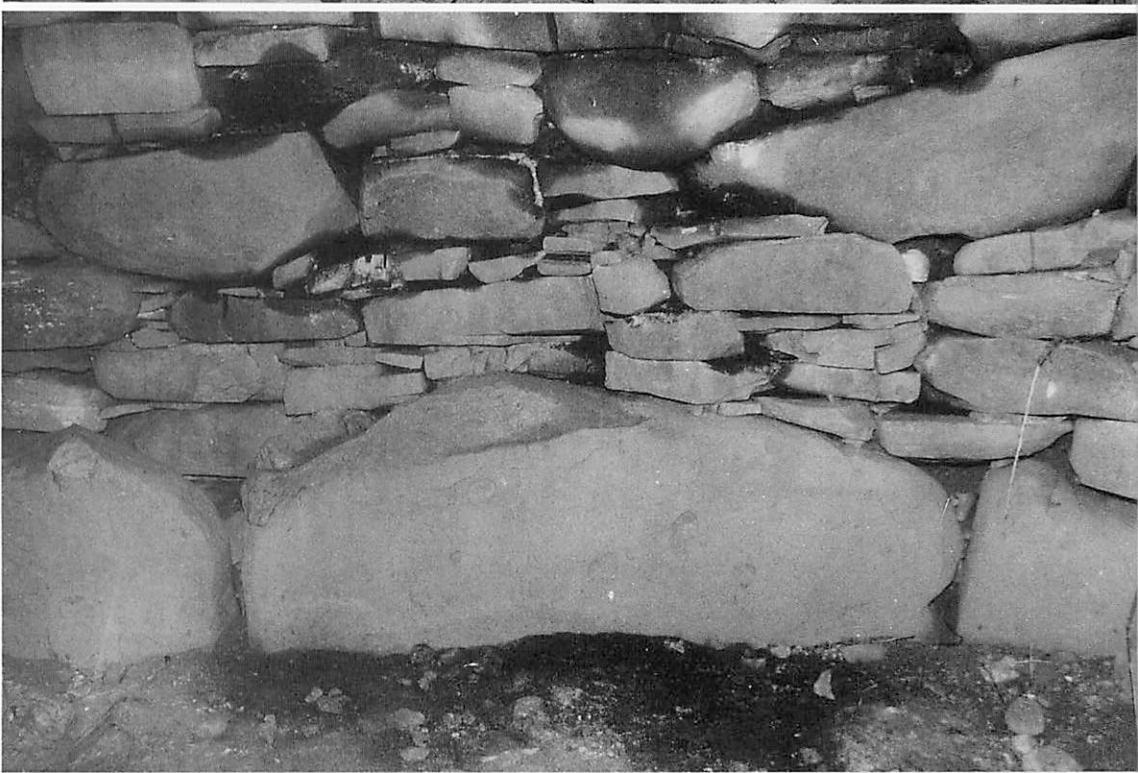
二軒小屋古墳 玄室右側壁
