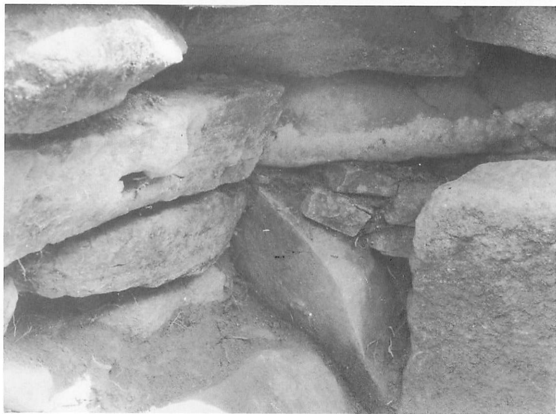
上 5号墳羨道部 下 5号墳石積の状況 (左・奥壁)
