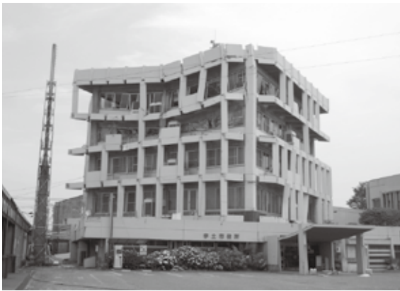
（写真1）立入り禁止になった宇土市役所（2016年5月27日撮影）
