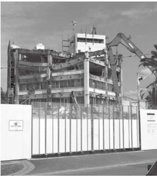
（写真6）解体工事中的の本庁舎（2016年9月7日撮影）
